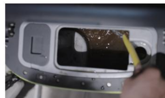
nettoyage du réservoir d'eaux usées
